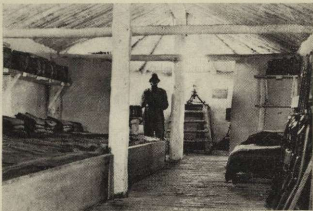
Interno di un piccolo caposaldo (con piazzuole ai due lati dell' alloggiamento)
