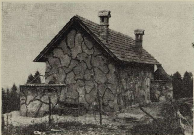
P. F. - Casello ferroviario sistemato a difesa
