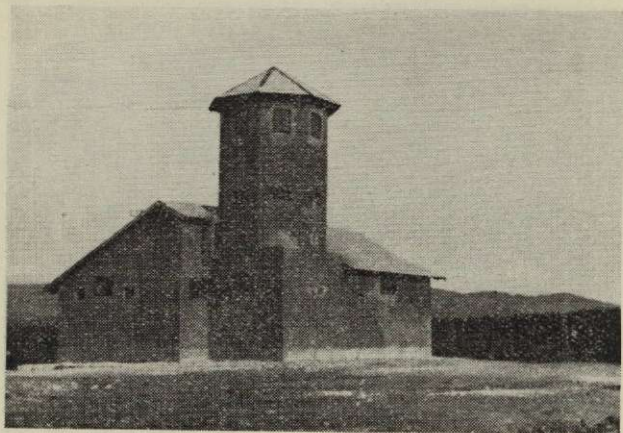
Caposaldi costituiti da edifici sistemati a difesa
