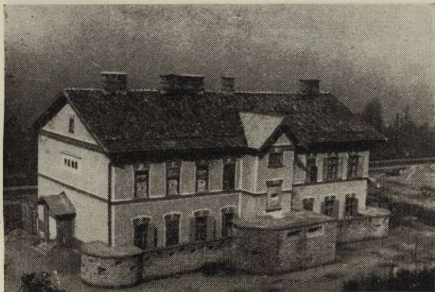
Caposaldi - Stazioni ferroviarie sistemate a difesa
